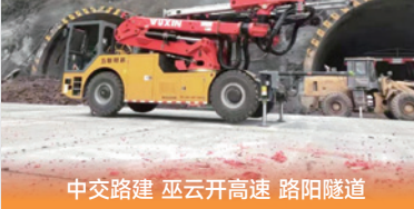
中交路建 巫云开高速 路阳隧道
