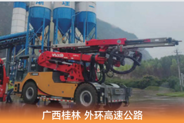
广西桂林 外环高速公路
